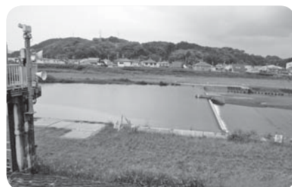
太田川円田の取水現場
